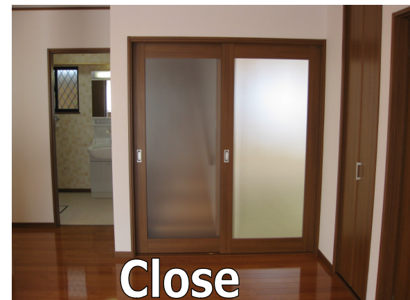
リビング階段が目隠しされ、光熱費も助かる～！ ガラス建具を入れる事で、明るさも保たれNICEアイデア！！
