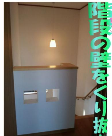
階段の壁をくり抜き抜き通風
